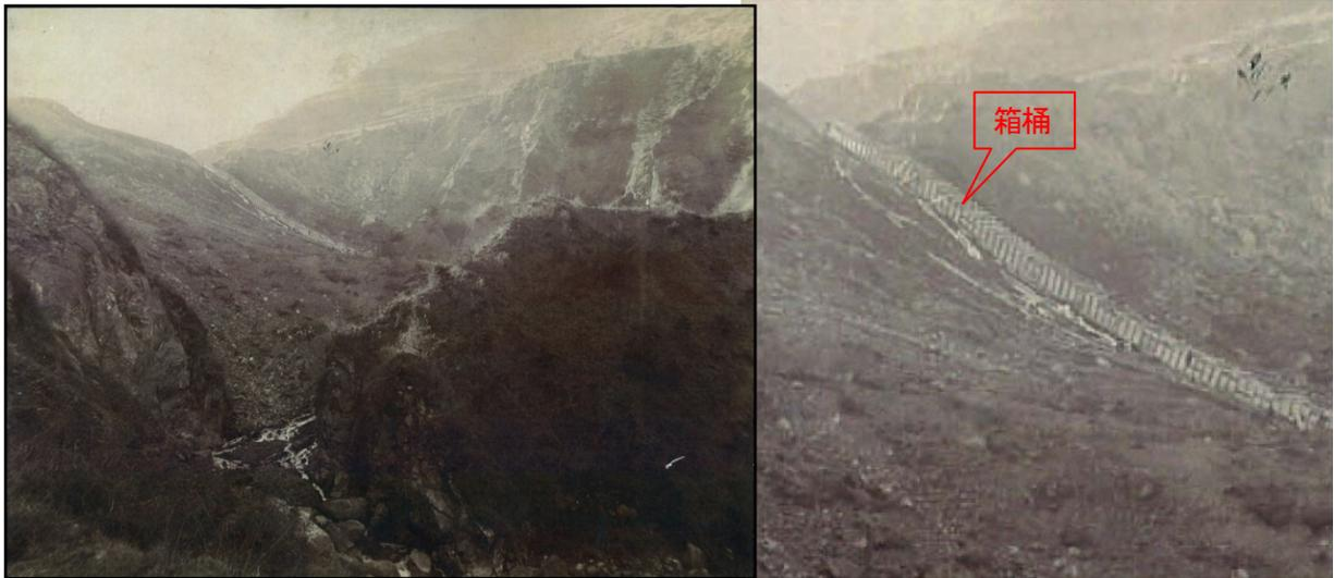
写真 2.42 排水假樋工事（箱桶）の設置状況と拡大写真（1900年2月27日通水）（山梨県砂防課蔵）
