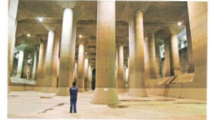
⑤首都圏外郭放水路（埼玉県春日部市）地下につくられている放水路で、大雨などで川の水になったときに水を取りこみ、川に排水するようになっています。
