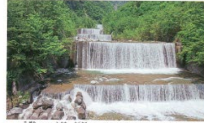
④砂防ダム（富山県立山町）大雨のときなどに、山や川の上流の砂が大量に流れることを防ぐものです。
