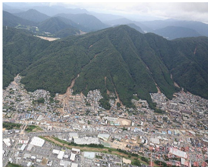
H26西日本豪雨時の 広島市土砂災害
