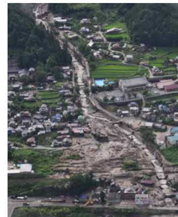
H26.7 長野県南木 曽町土石流災害
