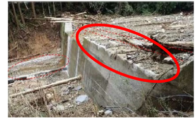
堰堤本体の広範囲にわたる欠損
