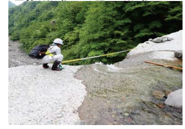
近接点検（従来の目視点検）
