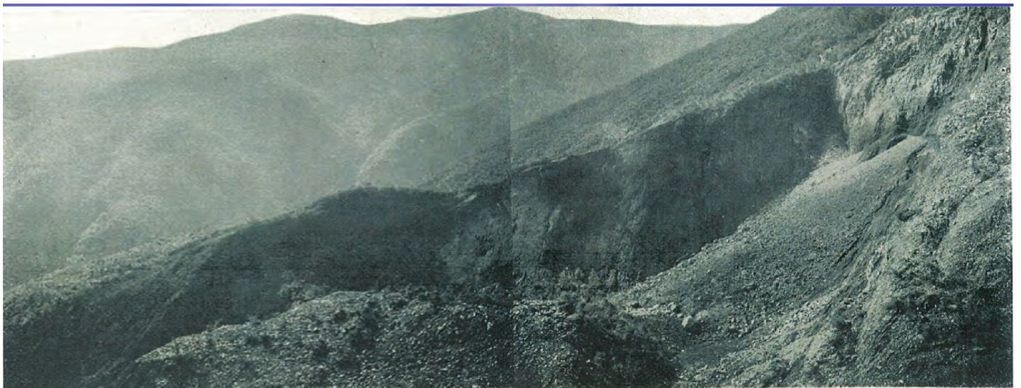
写真5.7 国有鉄道熱海線白糸川上流・大洞の深層崩壊（復興局，1927）
