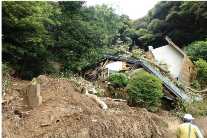
土砂災害後の状況写真
