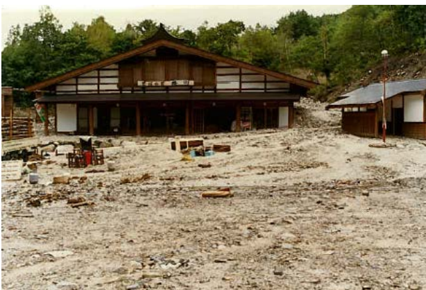
写真 被災状況（そばの里奈川周辺）
